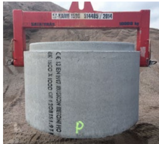
Kuva 4.14. Kuva 4.14. Nostopuomilla asennetaan suuria kooltaan Ø 1200, 1600 ja 2000 mm kaivonrenkaita.
