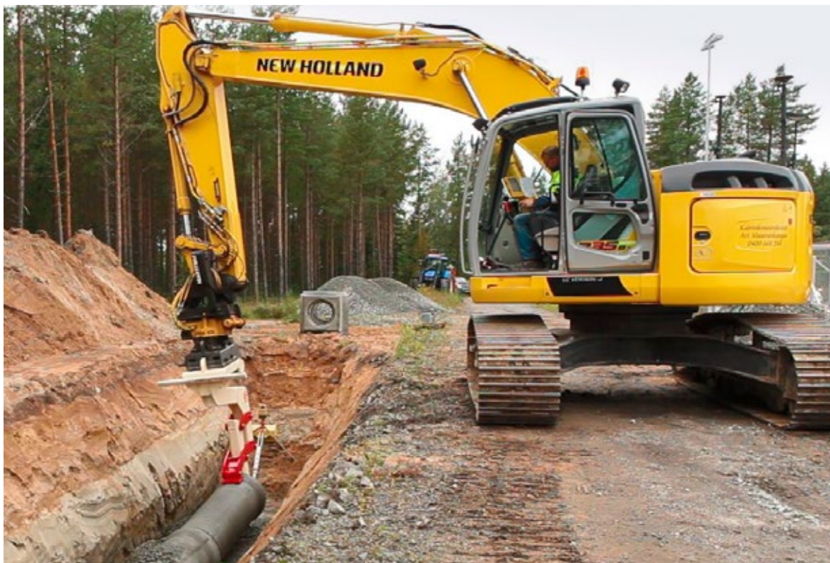
Kuva 4.8. Putken asentaminen asennusalustalle
