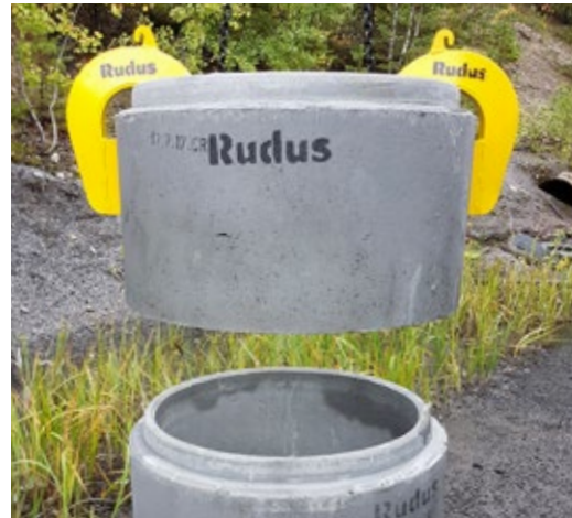
Kuva 4.13. Nostotarraimia on saatavilla kooltaan Ø 600....2000 mm kaivonrenkaiden asentamiseen.
