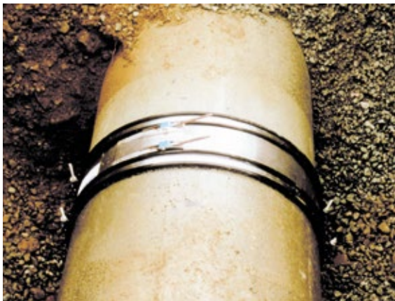
Kuva 7.2. Korjausmuhvin käyttö korjaustyössä.
