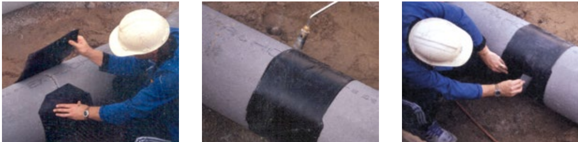
Kuva 7.1. Kutistenuhan käyttö betoniviemäriin korjaustyössä.
